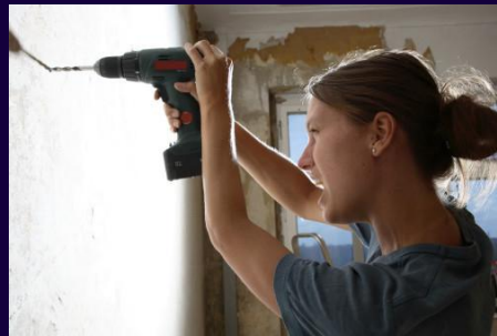
Gat in de muur
